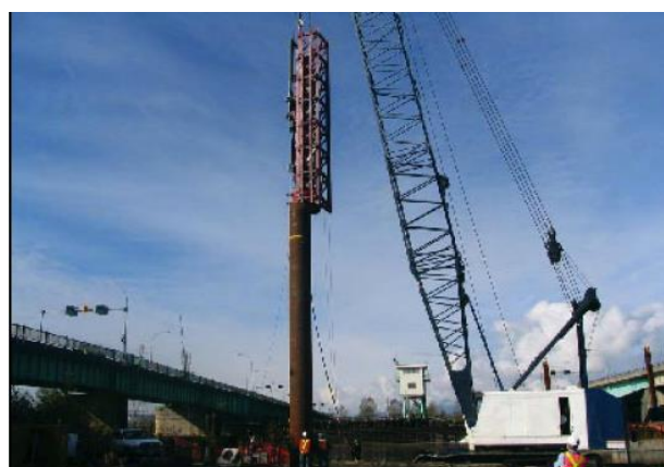
молот D180-42, самый большой дизельмолот в Северной Америке, погружает 42-дюймовую трубу
