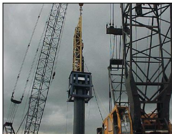
АРЕ модель D80 погружает трубу большого диаметра в Луизианне
