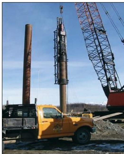
молот D180-42, самый большой дизельмолот в Северной Америке, погружает 42-дюймовую трубу
