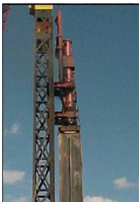
АРЕ модель D80 погружает трубу большого диаметра в Луизианне
