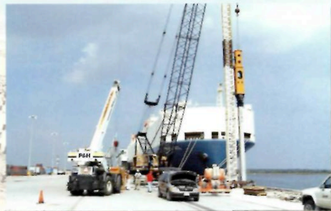
DKH-7 на кране с коробчатой направляющей при забивке железобетонных свай
