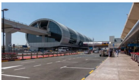
Станции наземного метро
